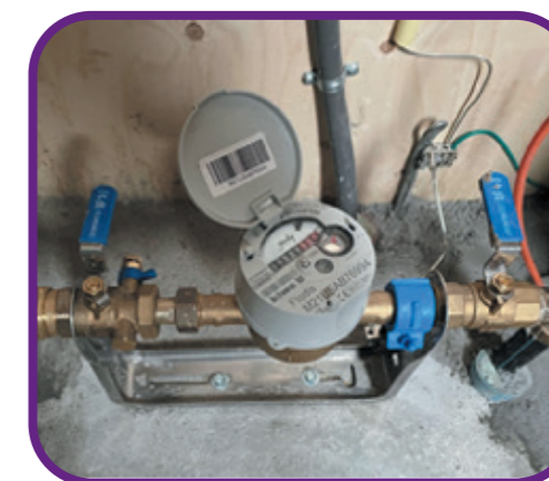
Watermeter in de meterkast
